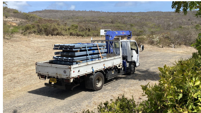
临建围挡 材料进场
