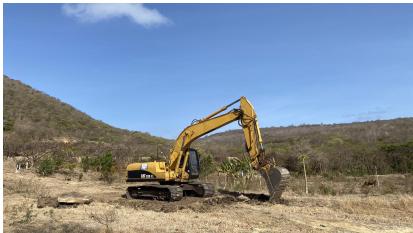
挖机场平施 工
