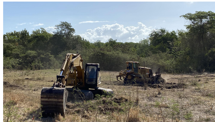
挖机和推 土机进行 场平工作
