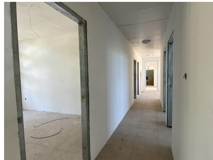
内墙和地砖完成
